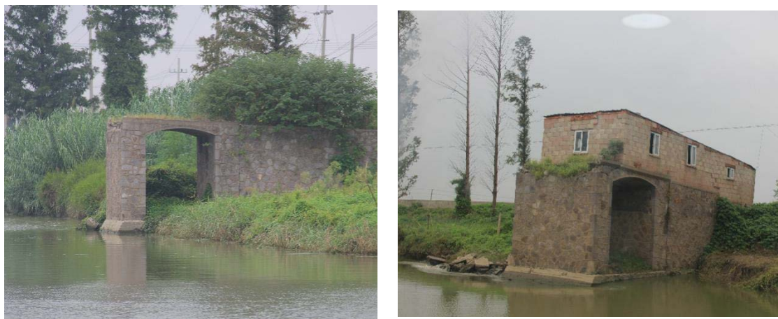
图 4-2 中河废弃桥墩
