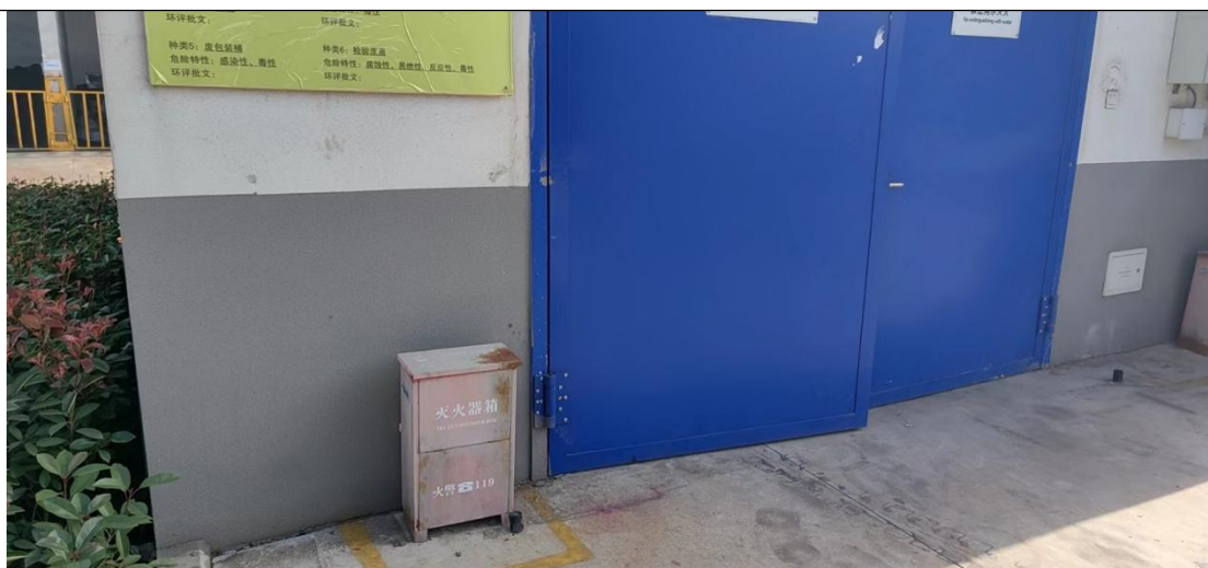
危废房外部照片
