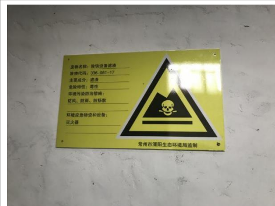
照片 6-贮存设施内部警示标志牌
