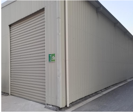
一般固废贮存区
