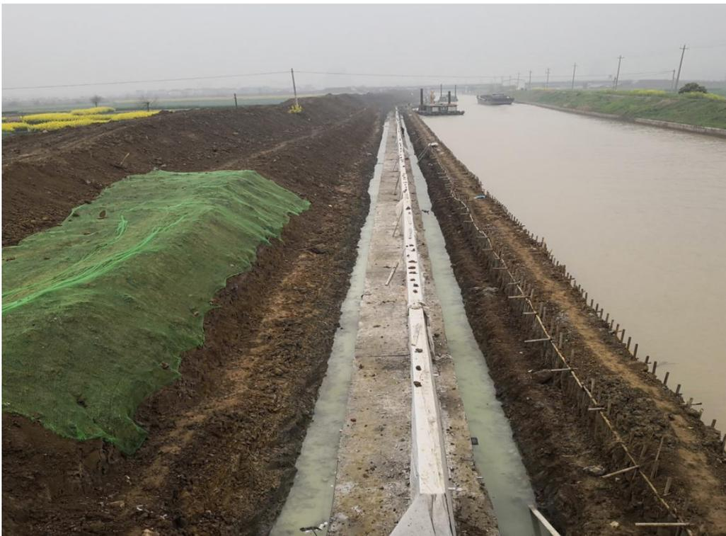
混凝土挡墙墙后土方回填
