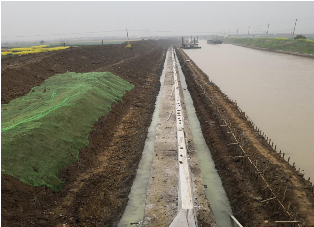
混凝土挡墙墙后土方回填
