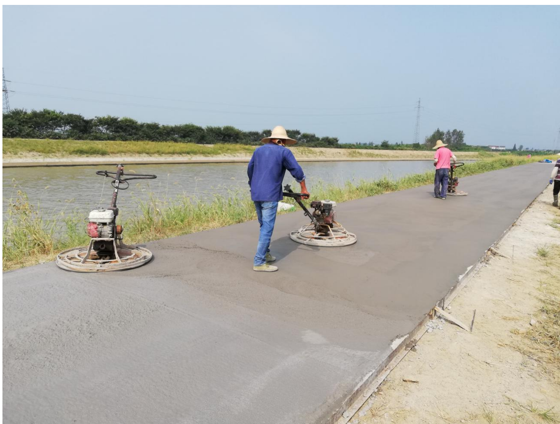
防汛道路施工
