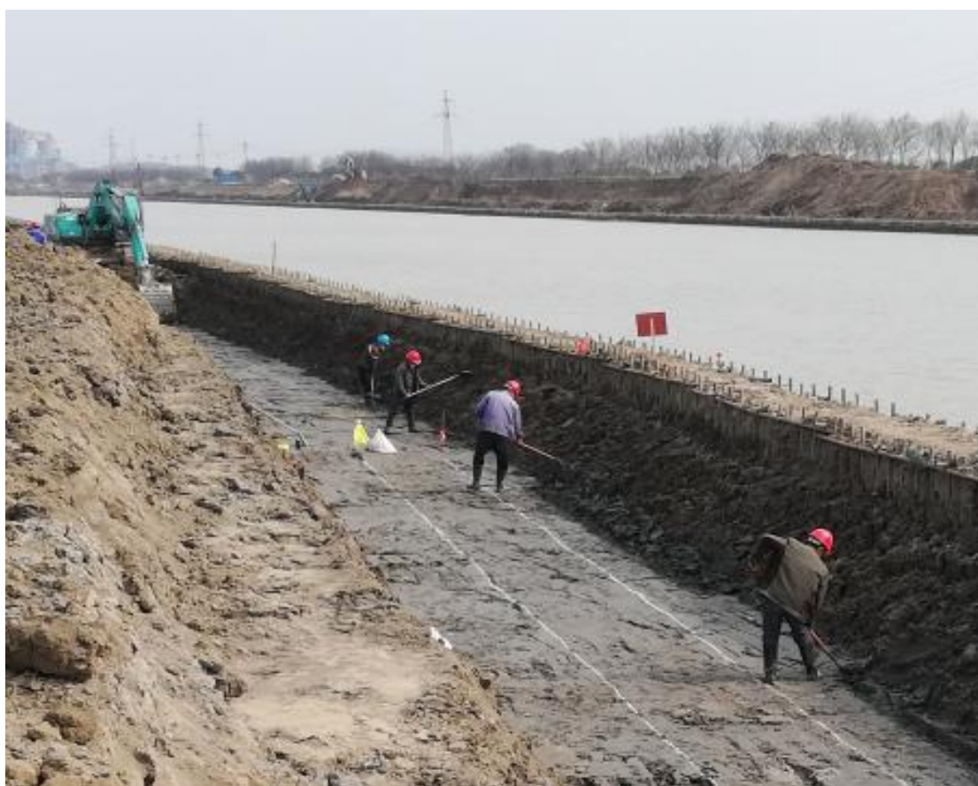
挡墙基坑开挖
