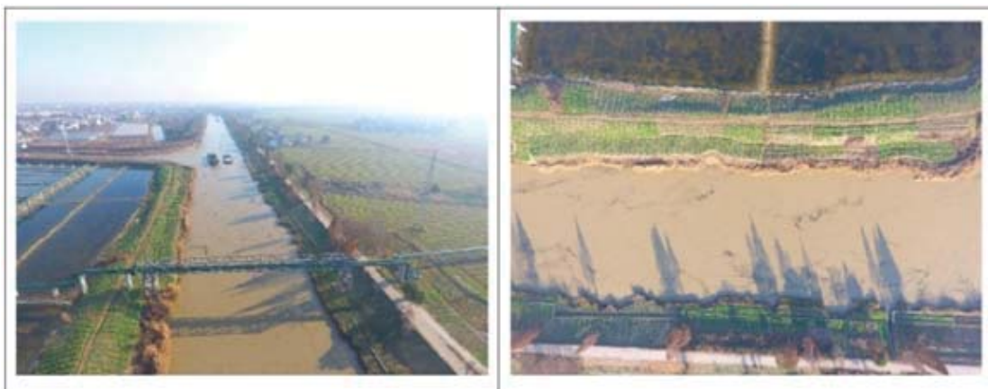
图 5.1.2-4 取水口现场照片
