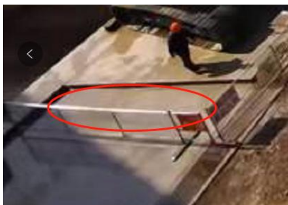
码头区沉淀池
