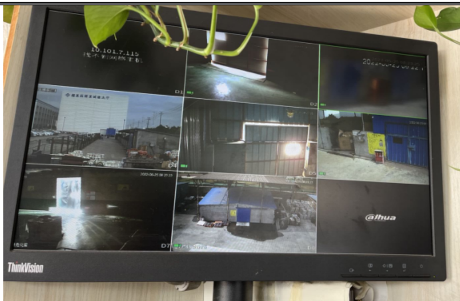
危废库内外监控、中控联网画面
