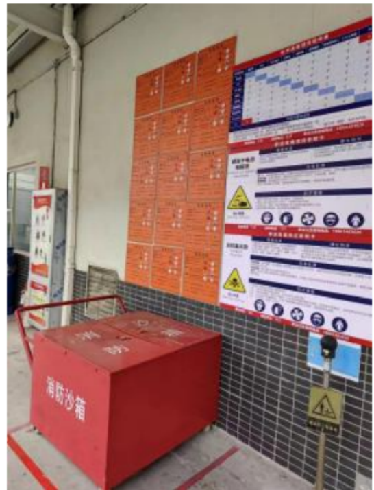
危废库房应急物资：灭火器、吸附棉、消防沙
