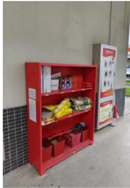
危废库 房外消防设施
