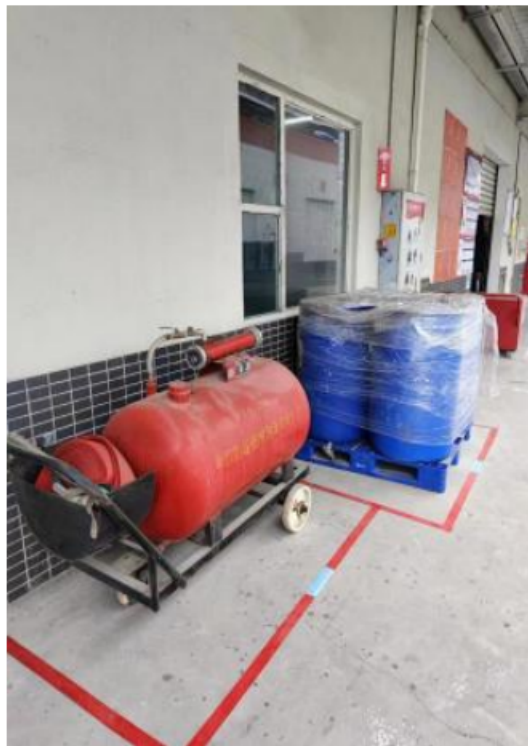
危废库房应急物资：灭火器、吸附棉、消防沙
