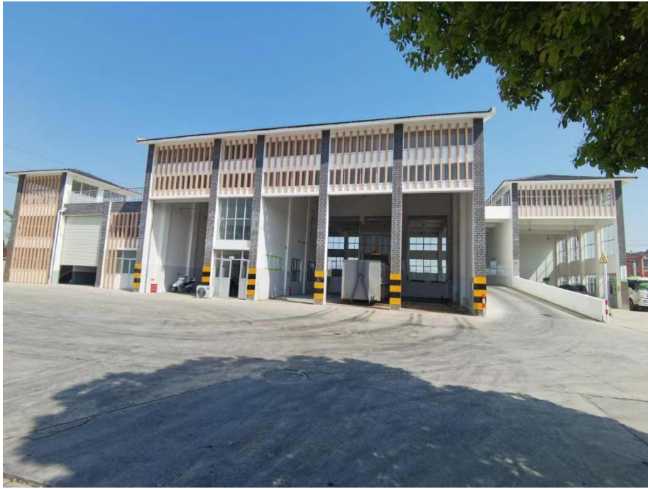
图 5.2-22 上黄垃圾中转站主体车间
