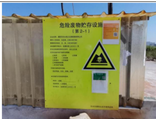
废酸贮存设施
