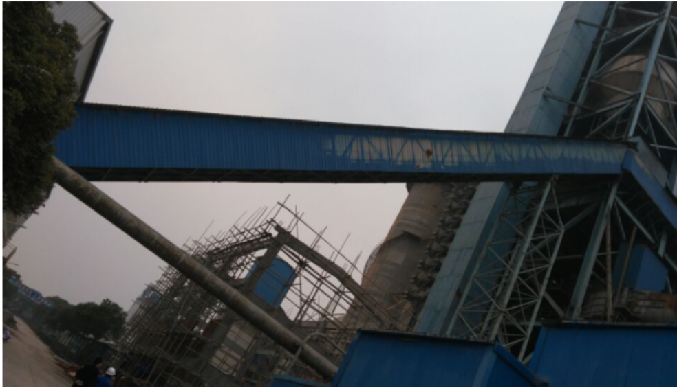
图 2-5 密闭的皮带廊道（污染土投加使用）
