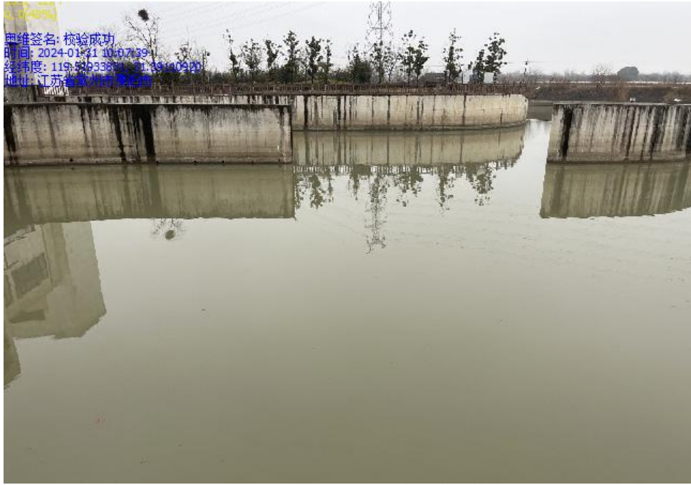
图 3.2-4 新区枢纽泵站外河侧现状图
