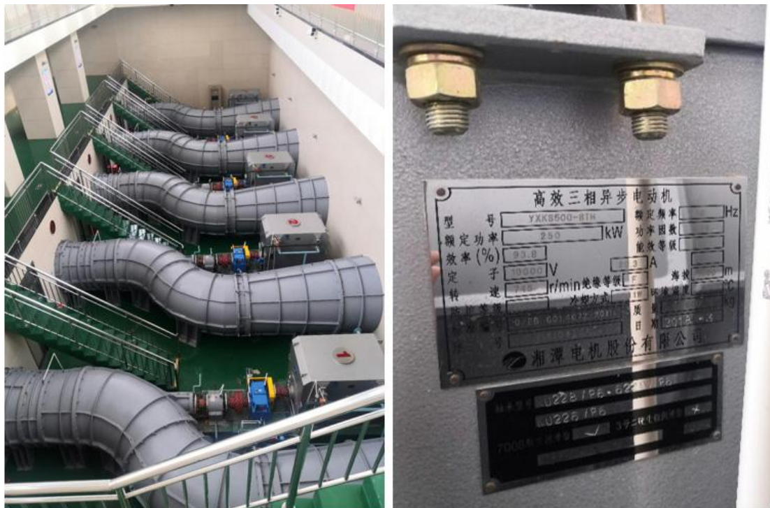
图 3.2-3 新区枢纽泵站现状图
