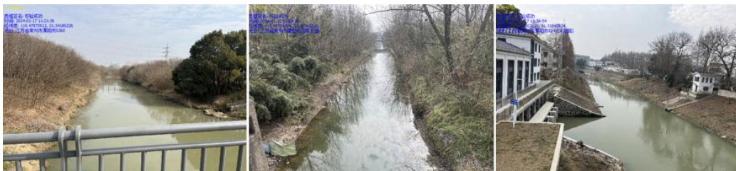
图 3.1-26 沙河水库溢洪河现状图
