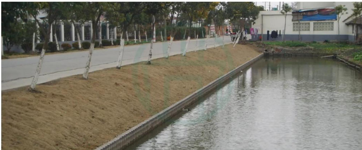
图 2-11 仿木桩护岸结构示意图
