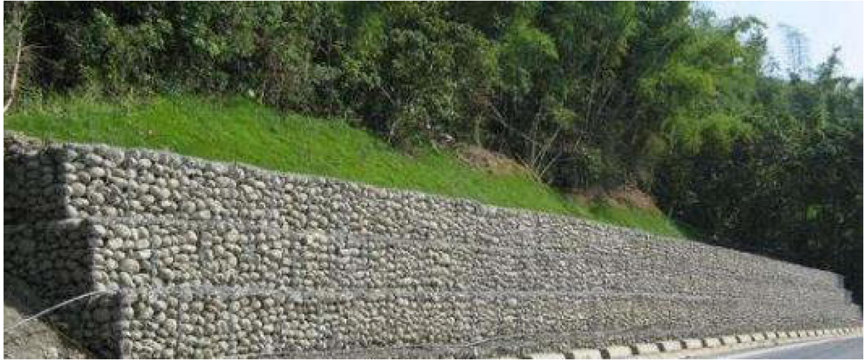
图 2-12 格宾石笼结构示意图
