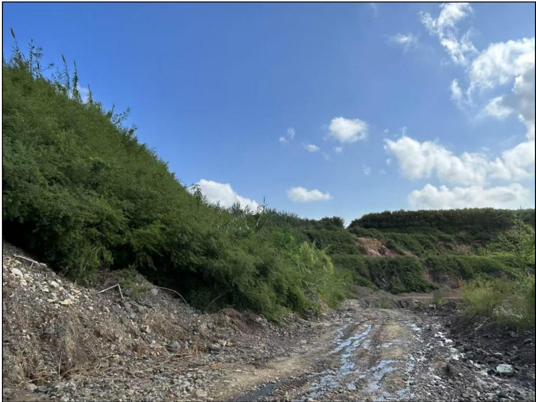
图 3-8 东北边坡生态修复后照片（近照）
