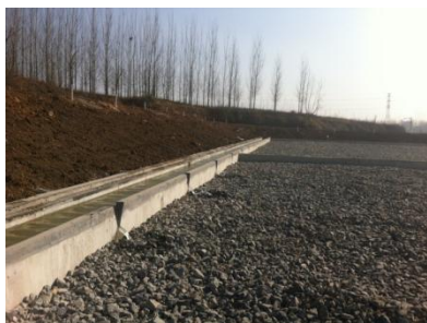
钢筋混凝土围墙
