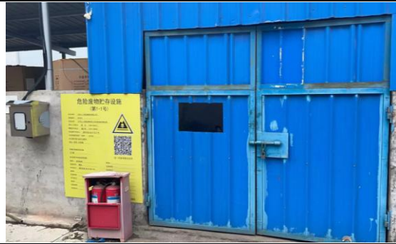
观察窗、贮存设施警示标志牌、消防设备
