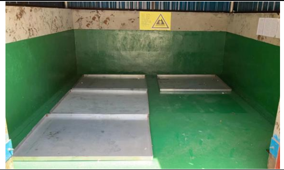
地面与裙脚硬化、防渗处理
